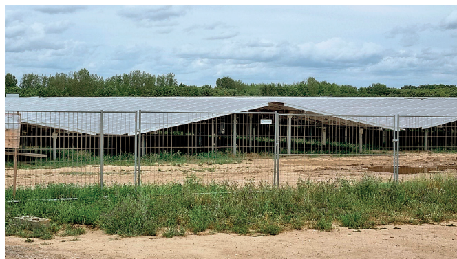
Abb. 1: Ost-West-Modulflächen des im Juli 2023 in Bau befindlichen Energieparks Witznitz auf rekultivierten Braunkohleflächen. (Foto: Dieter Günnewig, Juli 2023)
