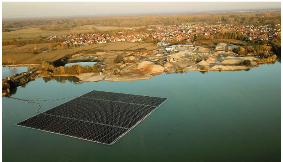
Abb. 1: Floating-Photovoltaik-Anlage in einem Baggersee bei Leimersheim nordwestlich Karlsruhe. (Foto: Erdgas Südwest)
